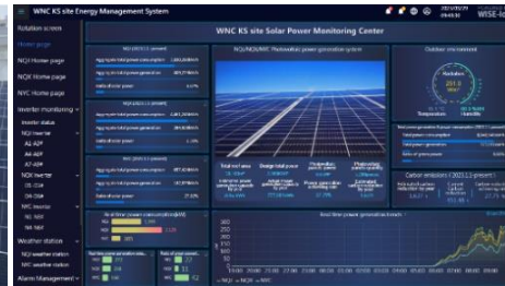
中國據點太陽能板發電監控介面
