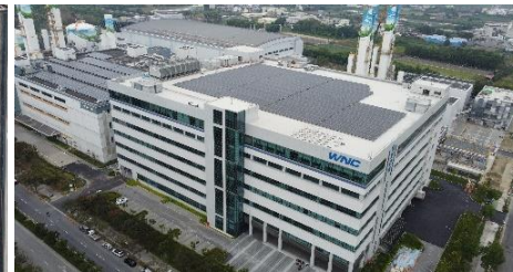
啓碁南科廠太陽能發電站
