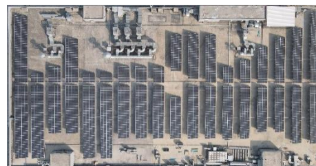
越南據點太陽能發電站建設
