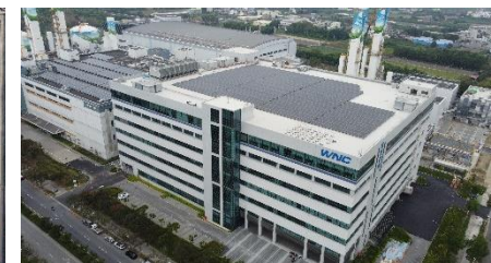
啓基南科廠太陽能發電站
